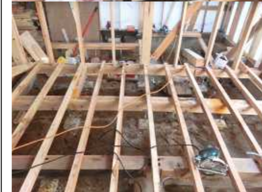
床ネタを取り付け中。既存の土台のねじ れを調整しながら一本、一本調整して取り 付けをしています。
