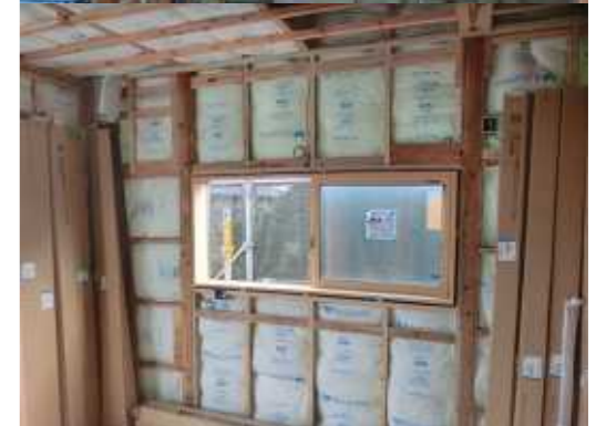
壁下地工事最近の業者さんは壁の下地 をしないで行う所が増えていますが弊社は 壁の下地を行っています。
